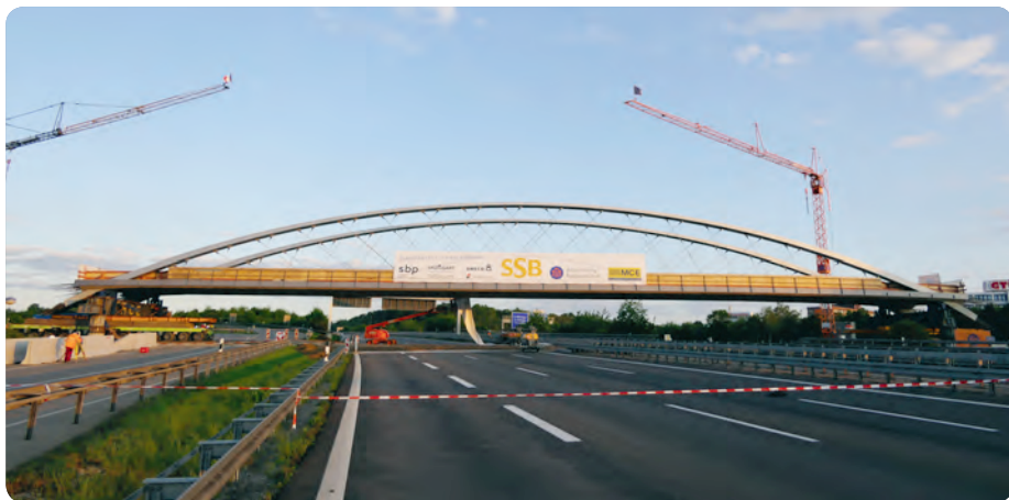
Die 72 Hängeseile der 127 Meter langen Zugbrücke wurden komplett aus Carbonfasern gefertigt. (Bild: Matthias Längle)
