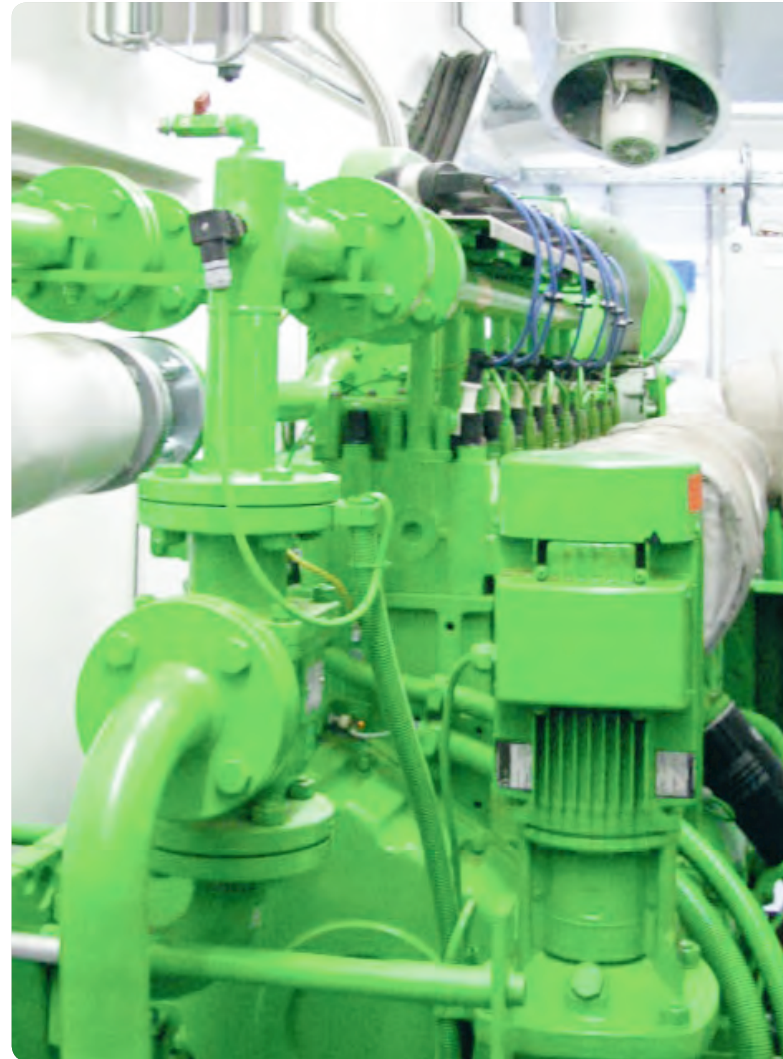
Kompaktes Erdgas-BKHW für Unternehmen mit Strom- und Wärmebedarf mit 300 Kilowatt elektrischer Leistung. (Bild: ECG)
