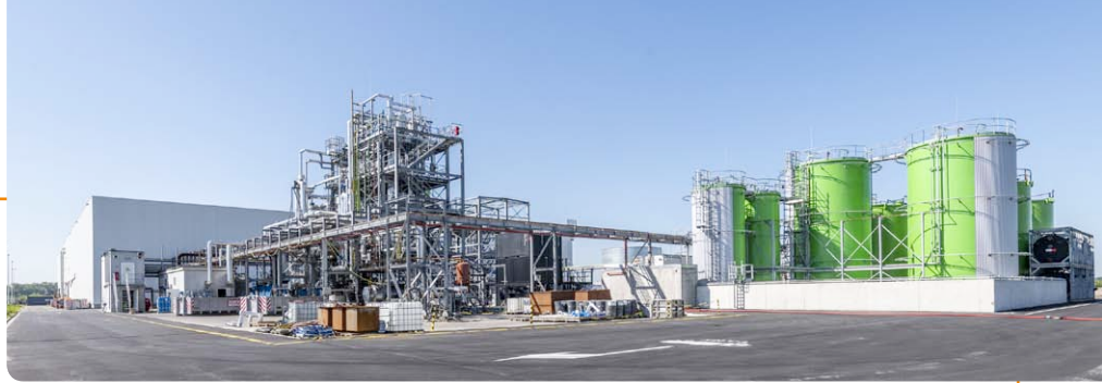
Borealis' kreislaforientiertes Kaskadenmodell ermöglicht die Verwertung mehrerer Abfallströme mit Hilfe unterschiedlicher Recyclingtechnologien. (Bild: Renasci)
