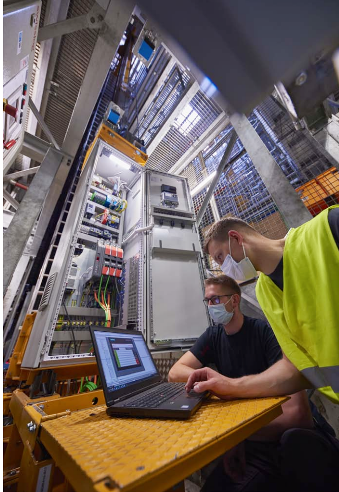
... Retrofit bei vollem Lagerbetrieb – dank minutiöser Planung und ... Wochenend-Einsätzen der Swisslog-Techniker.
