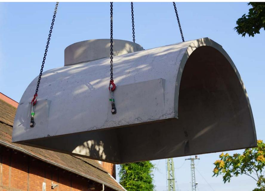
Sickeranlage Nord mit drei Rigolensträngen. Vom Lieferfahrzeug gehoben und in die Baugrube abgelassen werden insgesamt 18 Tunnel- und sechs Tunnelend-Elemente. Foto: Mall
