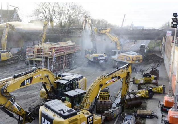
Insgesamt fünf Abbruchzangen von Epiroc kamen beim Rückbau zweier Eisenbahnbrücken bei Mülheim an der Ruhr zum Einsatz.
