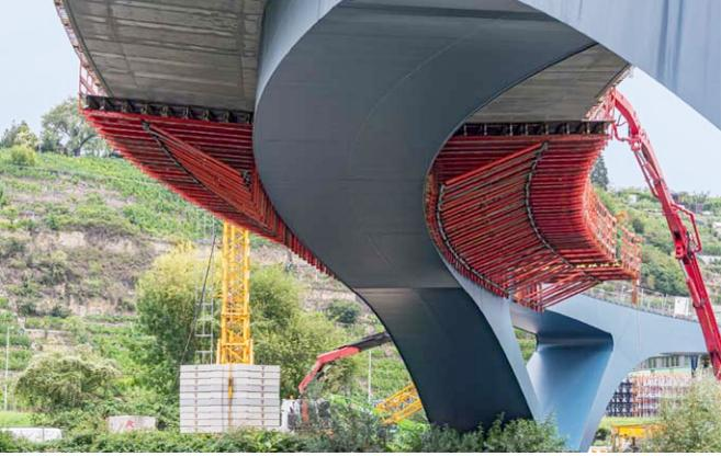
Der elegant geschwungene Brückenneubau über den Neckar ist als Stahlverbundbrücke mit schmalen Stahlgurt und weit auskragendem Betonüberbau ausgeführt.
