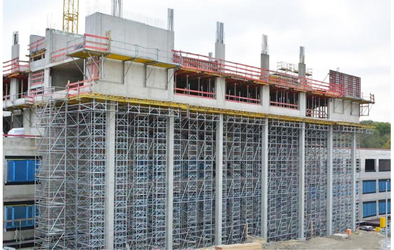
Das Allround Traggerüst TG 60 von Layher sorgte beim Bau eines Klinikgebäudes durch Anpassung an Lastvorgaben mittels variabler Feldlängen für effiziente Montage. Foto: Layher
