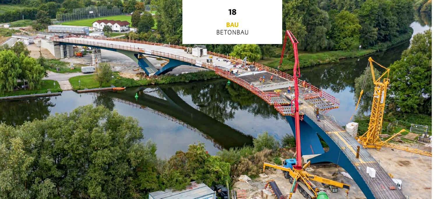
Die Herstellung des 195 Meter langen Brückenüberbaus und der Gesimskappen erfolgten auf Basis des Variokit Ingenieurbaukastens. Fotos: PERI
