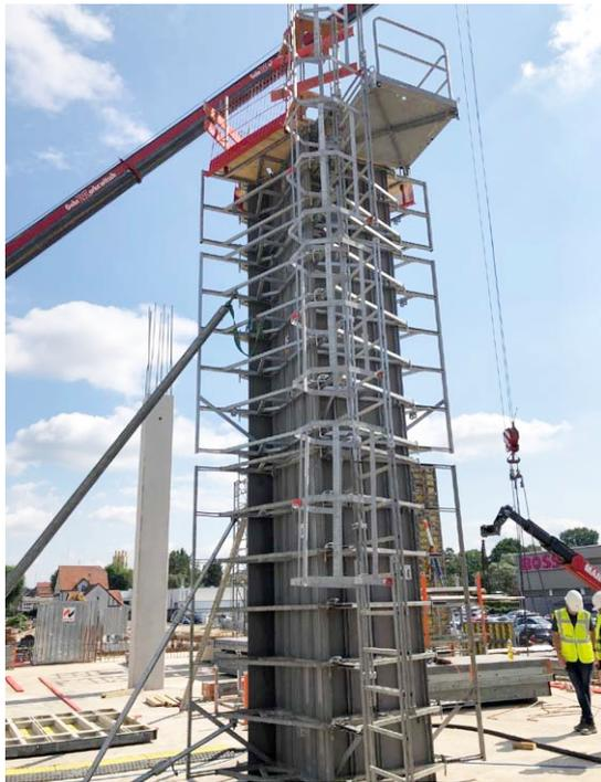
Rund 400 bis zu sieben Meter hohe Ort betonstützen betonierte das Klebl-Team mit klappbaren PAX HD Stützenschalungen von Mayer Schaltechnik.
