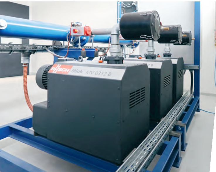
Eine zentrale Vakuumversorgung liefert bei Fuyao Europe das Vakuum für acht Produktionslinien. Bild: Busch Vacuum Solutions
